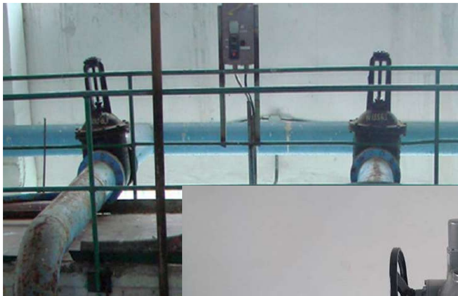
Заміна запірної арматури на запірну арматуру т.м. Hawle (Австрія)
